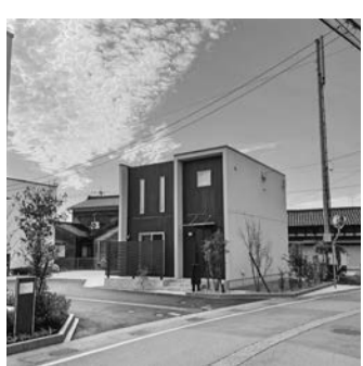
▶平な屋根の上に太陽光パネルが設置されている。
